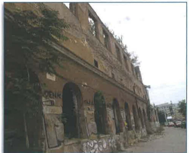
Objekat prve električne centrale, Sarajevo
