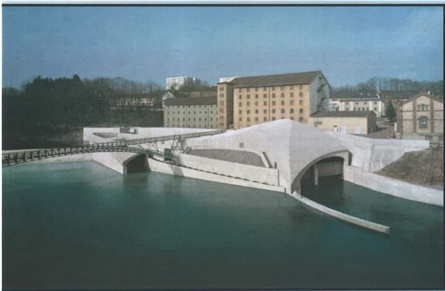
Slika male hidroelektrane u Kemptenu (Njemačka)
