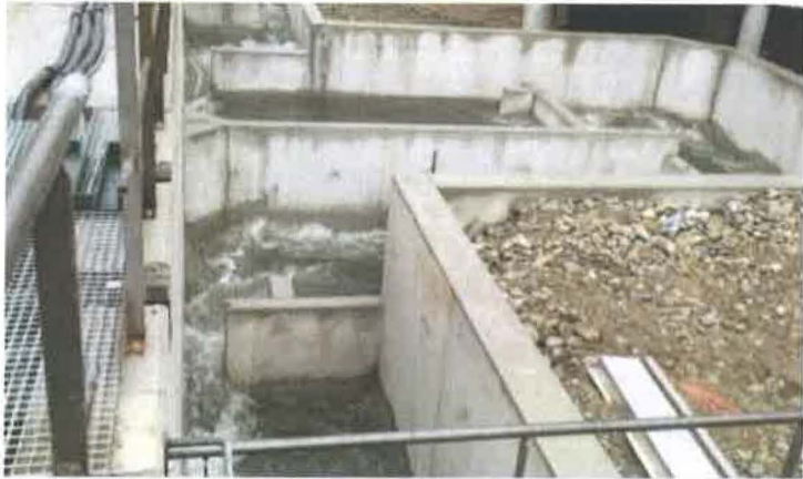
Slike izgrađene MHE sa Dive turbinom i prikazom riblje staze, čistilice i pozicije postrojenja
