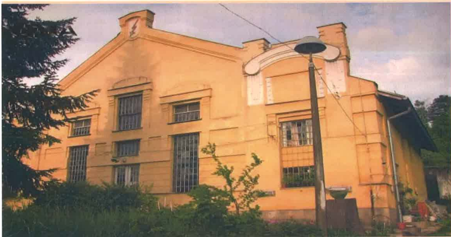
Slika izgleda mašinske zgrade male hidroelektrane Hrid
