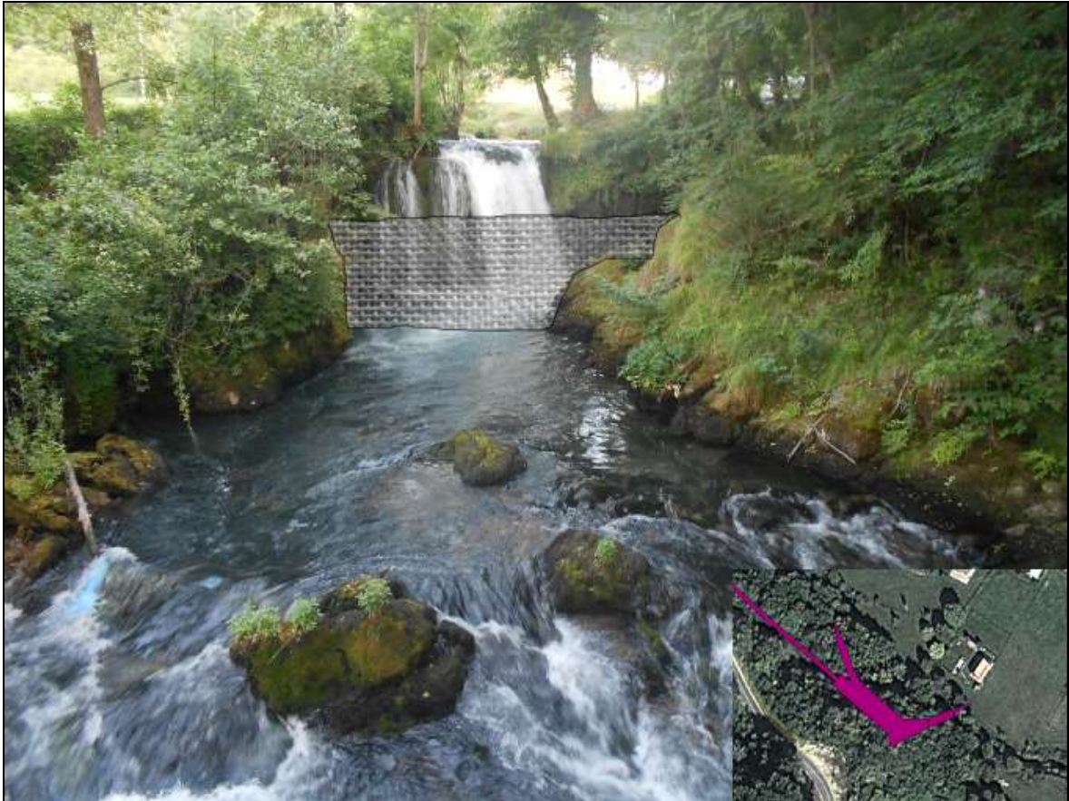
Слика бр. 4 Мјесто изградње уставе и водозахвата МХЕ Шипово
