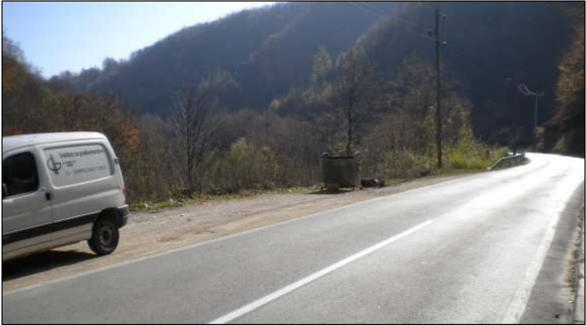
Слика бр. 41 Регионални пут Р-415 Шипово – Купрес, на слици је уједно и мјесто почетка сервисног пута дужине 815 м до машинске зграде МХЕ, као и средњенапонски вод 10 (20) kV електричне енергије за насеље Ј. Отока
