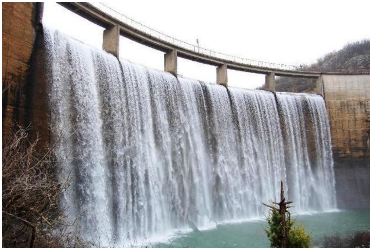
Слика број 12: Прелив на брани језера Ливеровићи, Црна Гора
